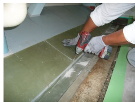
<FRP板取り付け>
